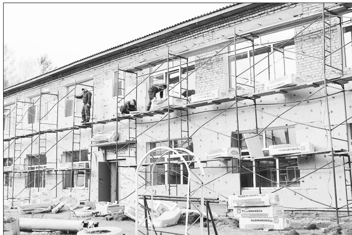
Утепление здания детского сада «Подснежник»
