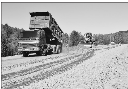
На дороге работает мощная техника
