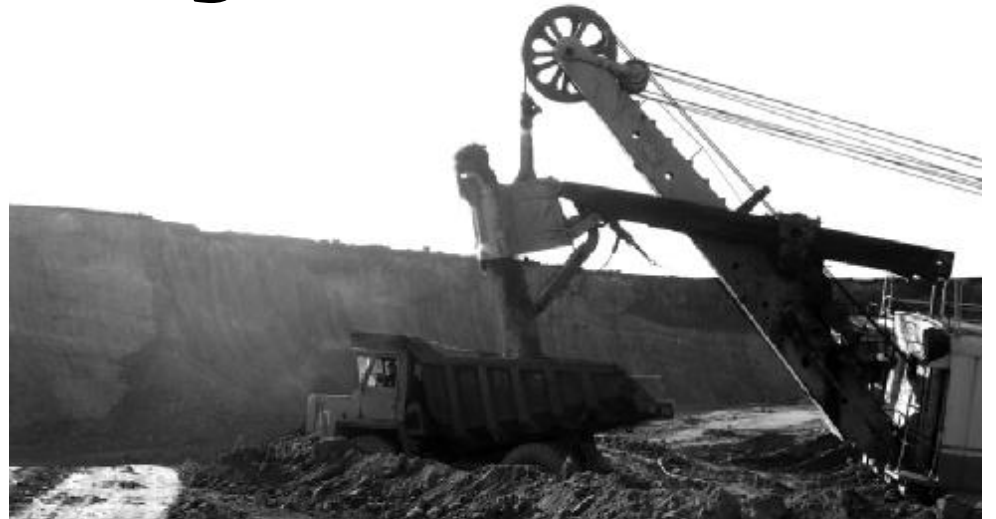
Идут вскрышные работы.
