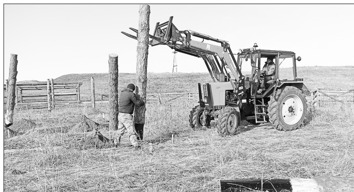
На участке застройки устанавливают столбы для навесов
