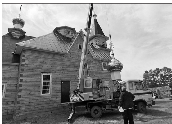
Идёт монтаж главного купола
