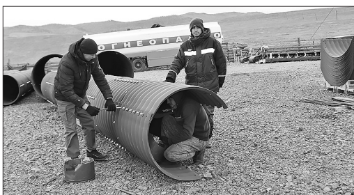
Сборка водопропускных труб
