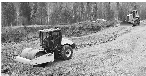
Утрамбовка грунта под водопропускные трубы
