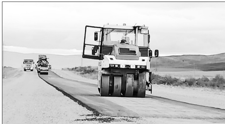
Ремонт республиканской дороги
