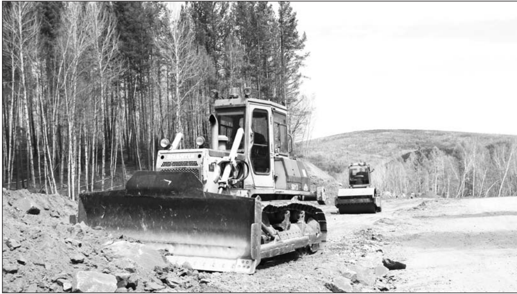
Мощная техника расширяет полотно дороги
