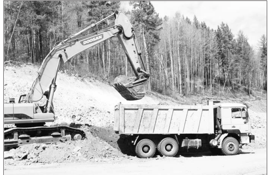
На отгрузке грунта
